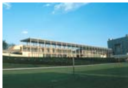
光都プラザ(生活関連施設)
