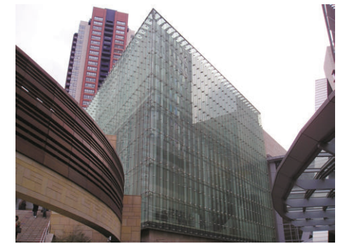
フジプレミアム製のフィルムラミネートガラスが採用されている東京中心部の商業ビル
