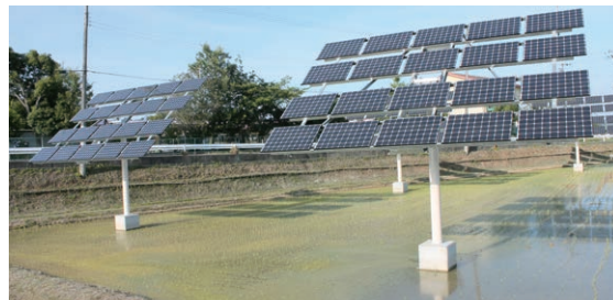
トラッキングシステムを設置した農地
