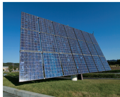
休耕地ではなく、農業用地に設置できるフジプレアムのトラッキングシステム。通常どおり作物を育てながら自家発電を行うことができ、土地の有効活用につながります。
