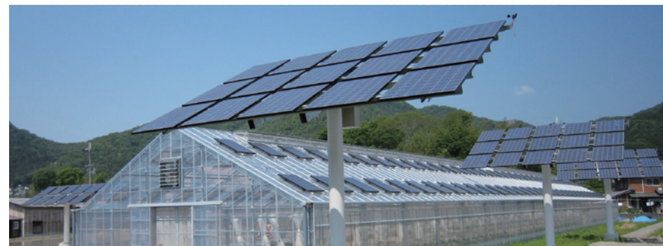
可動式太陽電池パネルが設置された農業ハウス。新たな栽培の研究も行われている。
