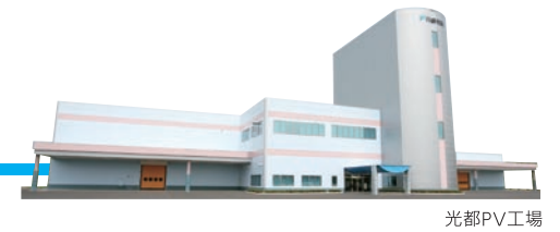
光都PV工場
