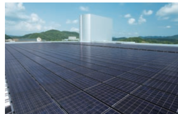
フジプレミアム光都PV工場の屋根には200KWの太陽電池モジュールを搭載。
